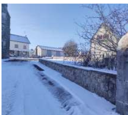
Muret restauré à côté de l'église
