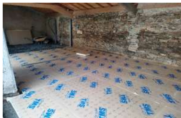
Habillage et isolation du sol
