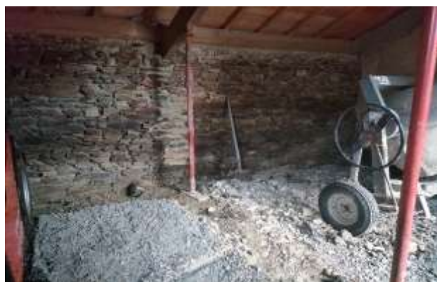
Réfection du mur en pierre
