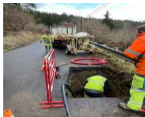
Travaux d'eau Gare de Bourgeade
