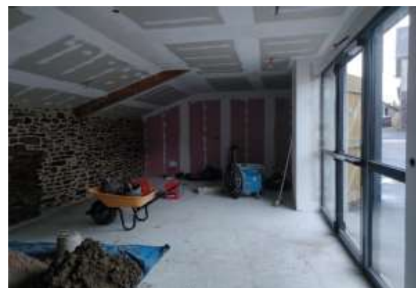
Rejointage du mur et pose de nouvelles fenêtres
