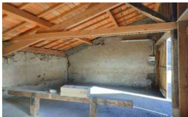
Etat brut avant travaux
