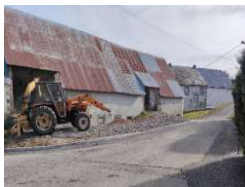
Travaux de sécurité à Barreix
