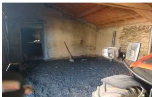
Réfection du sol
